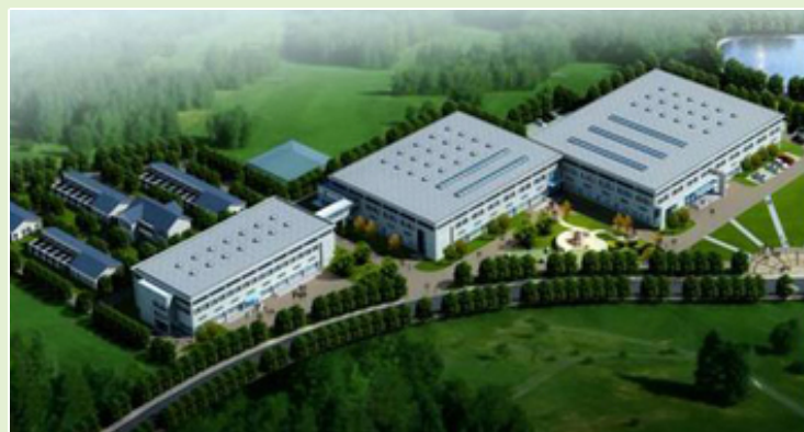
江苏省医药动物实验基地竣工并投入使用
